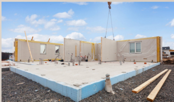
dom w trakcie budowy
